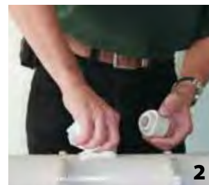
Зачистить. Если применяется труба Stabi, то у высверленного отверстия необходимо скосить фаску. Очистить и обезжирить фасонную часть и высверленное отверстие.
