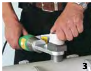
Вварное седло надеть на насадку так, чтобы были совмещены метки на седле и насадке. Прогреть отверстие и ввариваемое седло. Время прогрева насады у трубы диаметром 32 мм – 8 с. Для вварных седел 110 x 32 и 110 x 40 время нагрева такое же, как для диаметра 40 мм – 12 сек.
