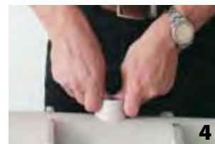
Нагретое седло всунуть в нагретое отверстие и зафиксировать примерно на 16 с. Через час систему можно заполнить водой и нагрузить давлением.
