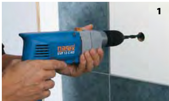
Просверленное отверстие рассверлить (откалибровать) сверлом 10 мм.
